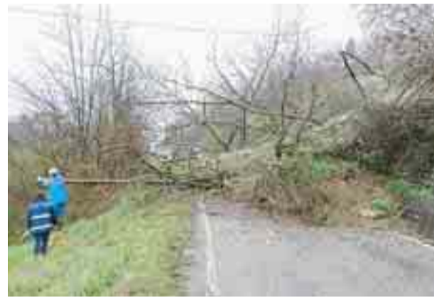
La frana che ha ostruito completamente via Gesso foto Sanna
