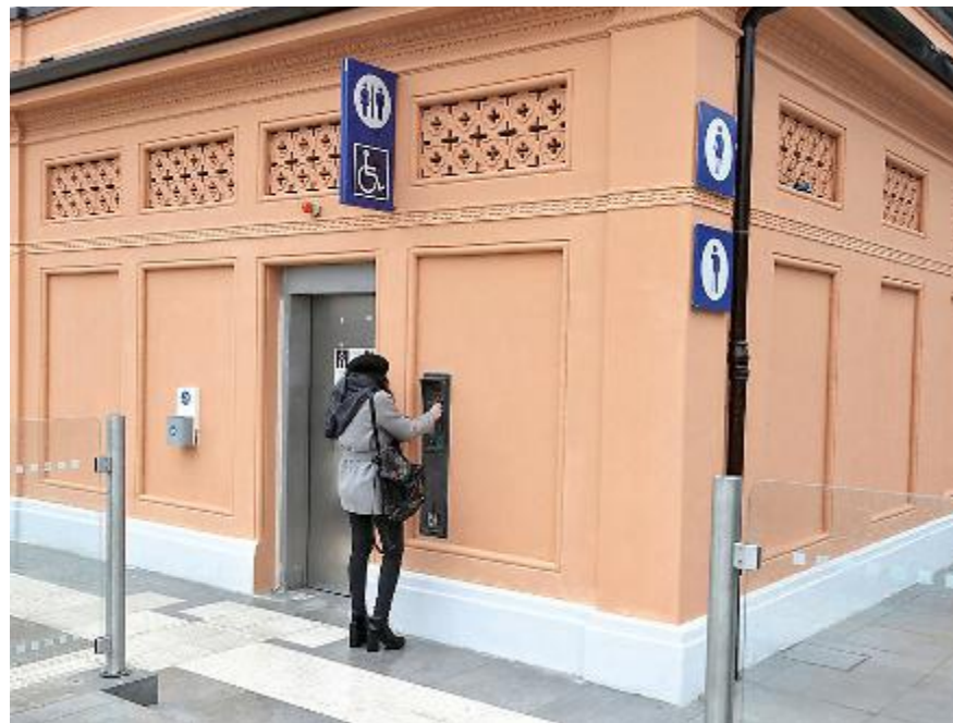
I servizi igienici della stazione ferroviaria. Sono due, ristrutturati da poco. Da venerdì a lunedì sono stati fuori uso
