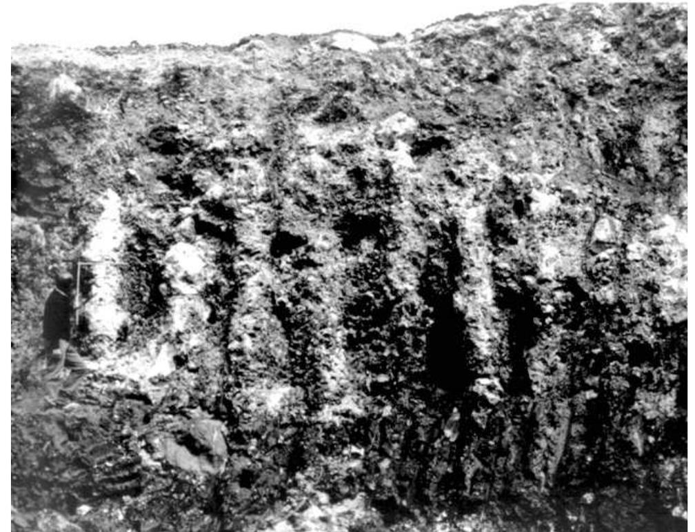
Costituiscono il metodo più attendibile per verificare la riuscita dei trattamenti (in termini di dimensione delle colonne e resistenza del soilcrete)
